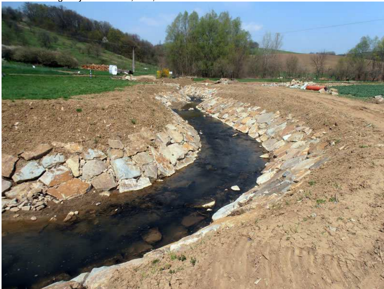
Vzorová ukázka kamenné rovnaniny s vyklínováním
